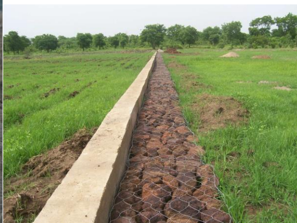
Image 3 : Seuil déversant en béton cyclopéen
