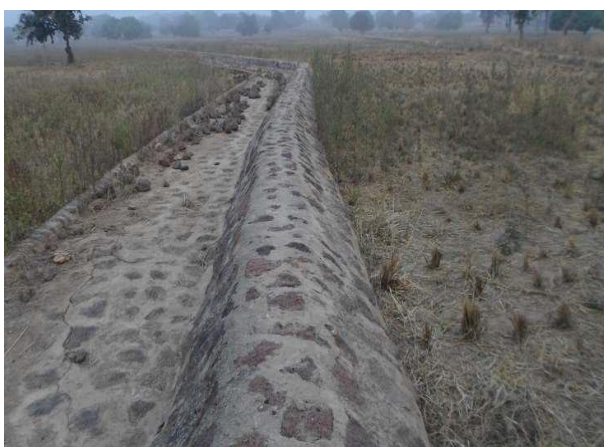
Image 2 : Seuil déversant en béton armé
