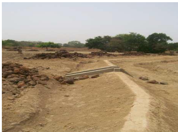
Image 4 : DCN Compacté non protégé
