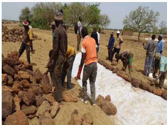
Image 5 : Pose de moellon après celle du géotextile
