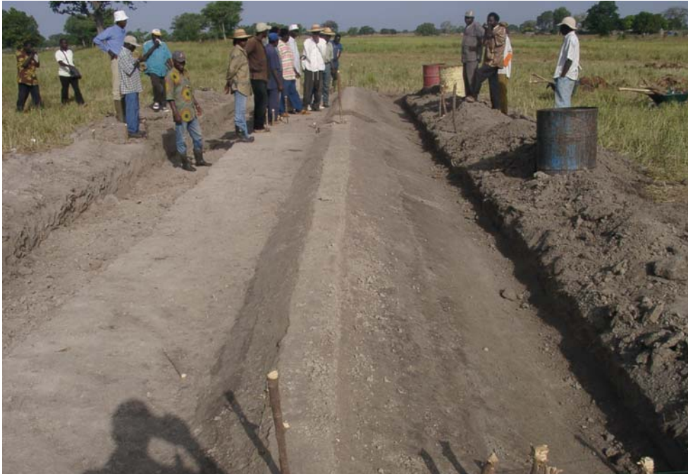
Photo 4 : Talutage d'une diguette de type T7 (PAFR)
