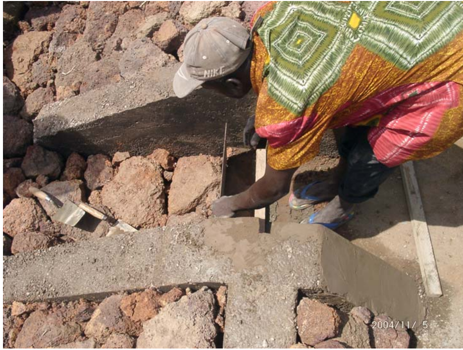
Photo 7 : Mise en œuvre d'un puits de vidange (PAFR)
