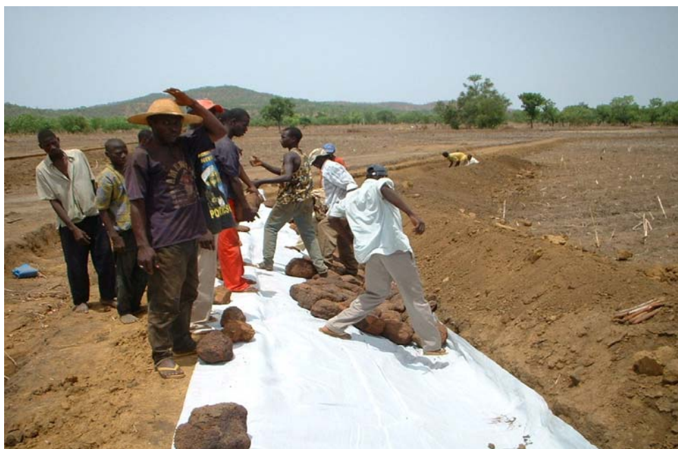
Photo 5 : Pose de polypropylène tissé faisant office de géotextile (PAFR)
