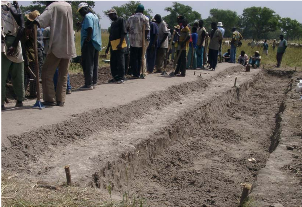
Photo 3 : Remblai compacté avant talutage (PAFR)
