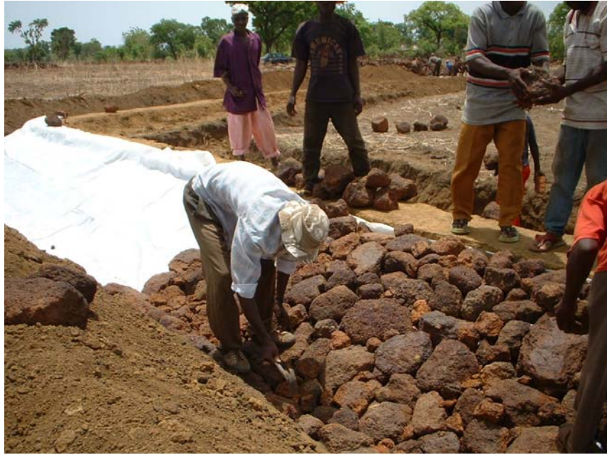
Photo 6 : Pose de moellons (PAFR)
