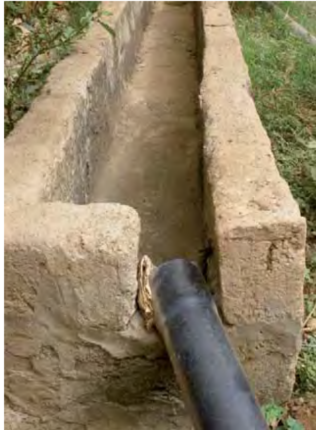
Photo 39. Canal revêtu en béton. Coopérative des Frères Diallo, Kayes.
