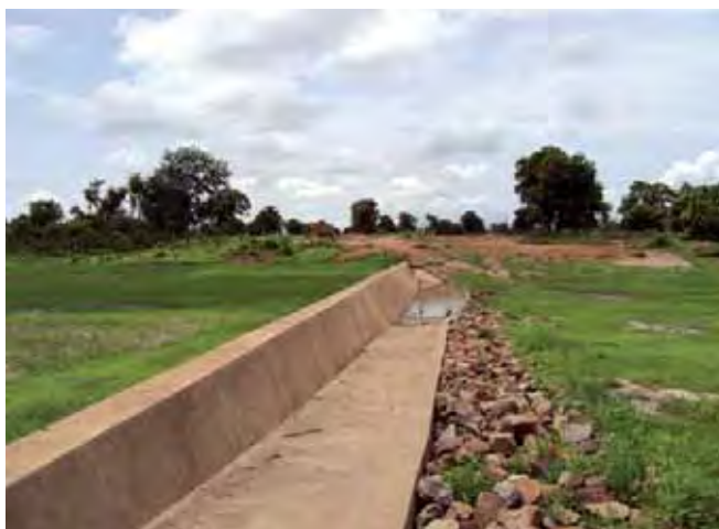
Photo 31. Bas-Fond de béton du PDRIK. Kita.
