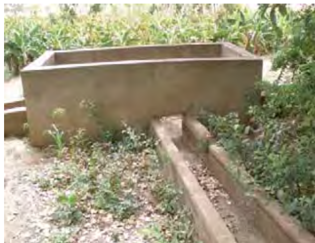
Photo 40. Chambre rectangulaire (regard) en béton. Coopérative des Frères Diallo, Kayes.
