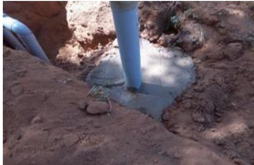
Image : Fixation des bornes (manchons)
