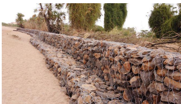
Photo 13 : Protection des berges en gabions
