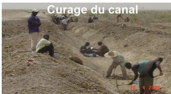
Photo 15 : Travaux de dévasement d'un canal d'irrigation
