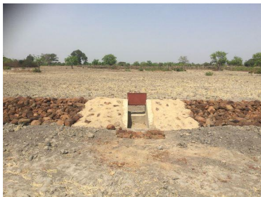
Photo 7 : Diguette en courbe de niveau munie de pertuis
