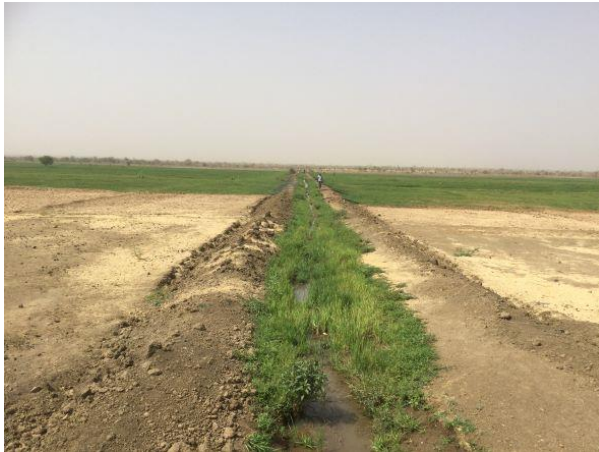
Photo 14 : Canal d'irrigation en terre
