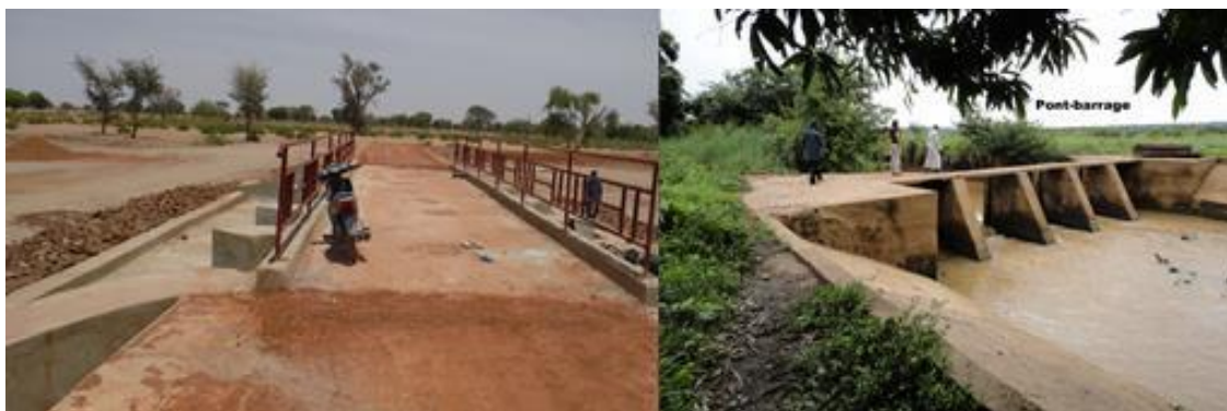
Photo 20 : Ouvrage de franchissement
