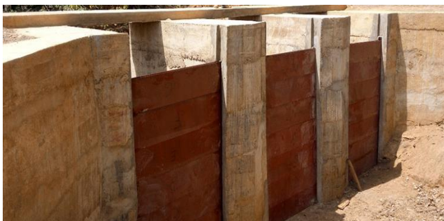
Photo 19 : Batardeau en bois
