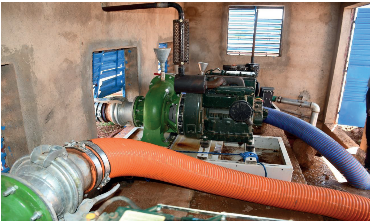
Photo 3 : Motopompe + flexible aspiration et refoulement
