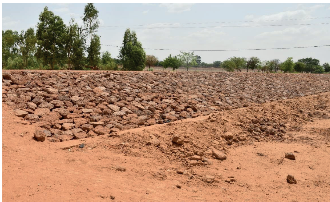
Photo 9 : digues de protection
