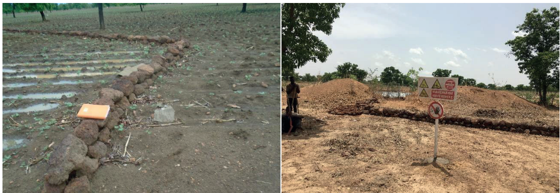
Aménagements de cordon pierreux en amont Diguette filtrante de protection du bassin
