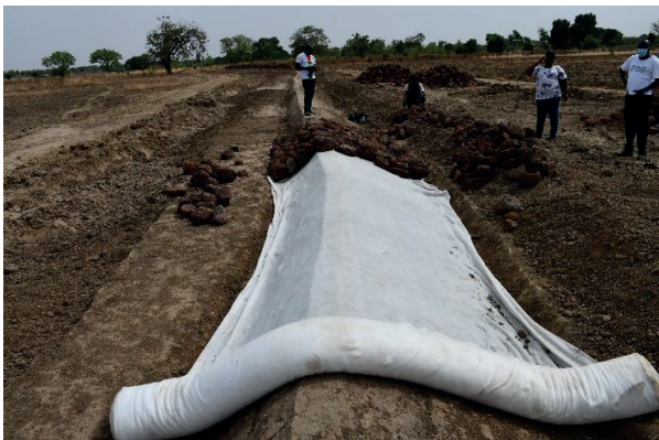
Photo 3 : pose de géotextile sur une DCN (site de Nébienbour)
