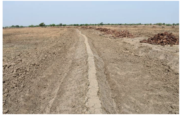
Photo 1 : diguette en terre compactée et talutée dans le bas-fond de Kelindou
