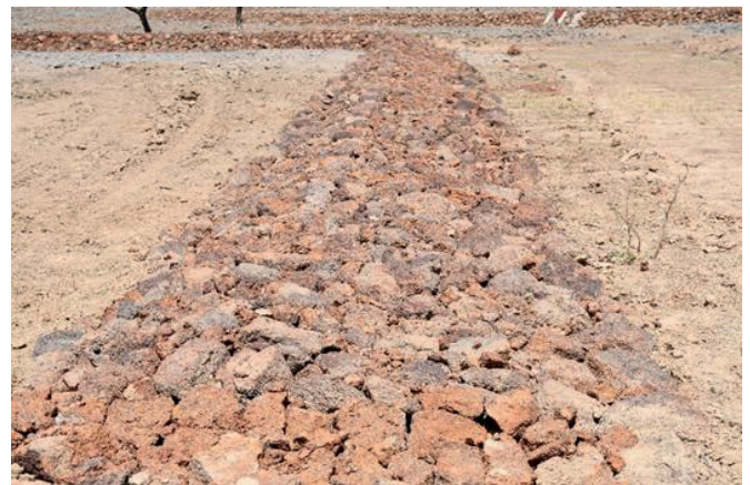
Photo 2 : DCN enrochée avec moellon (site de Sanflé)
