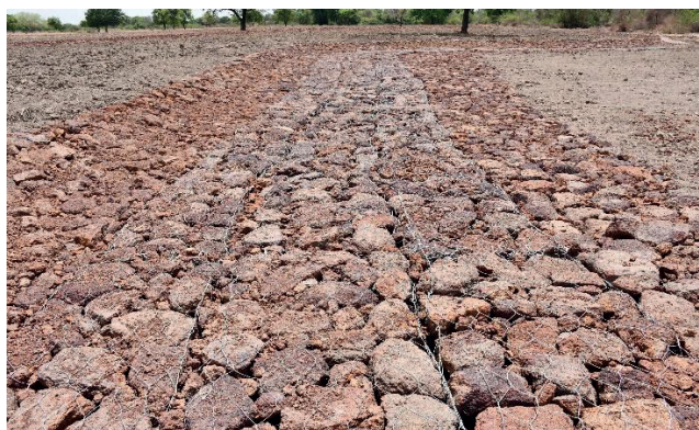
Photo 8 : traitement de ravines réalisé dans le bas-fond de Sanflé
