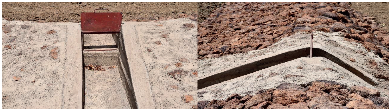
Photo 4 : pertuis de vidange vu de face et de profil dans le bas-fond de Sanflé
