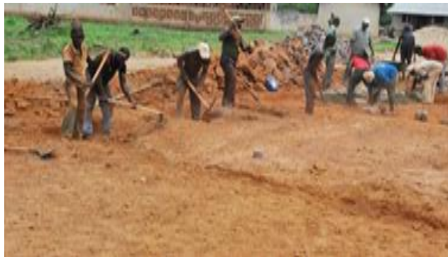
Photo 32 : travaux de réparation d'une piste
