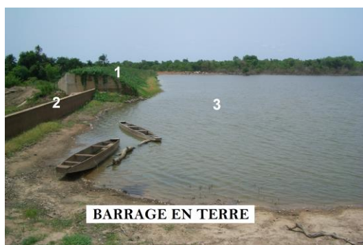
Photo 1 : Barrage en terre
