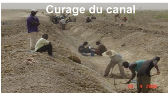
Photo 6 : Travaux de dévasement d'un canal d'irrigation.
