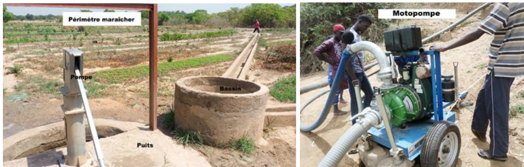
Puits équipé de pompe manuelle
