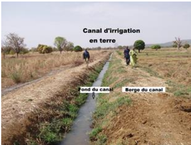
Photo N°5: Illustration d'un canal d'irrigation en terre
