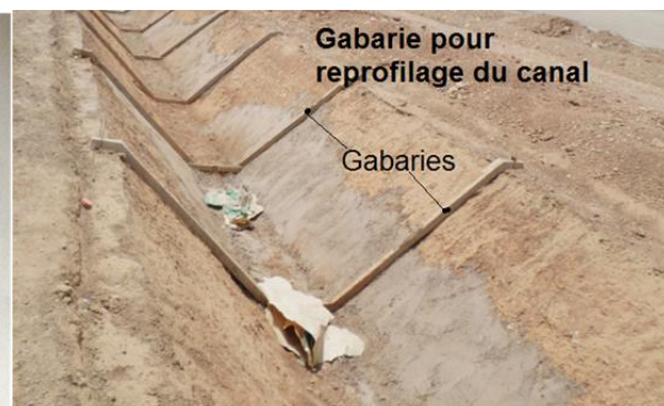
Photo 7 : Reprofilage d'un canal en terre
