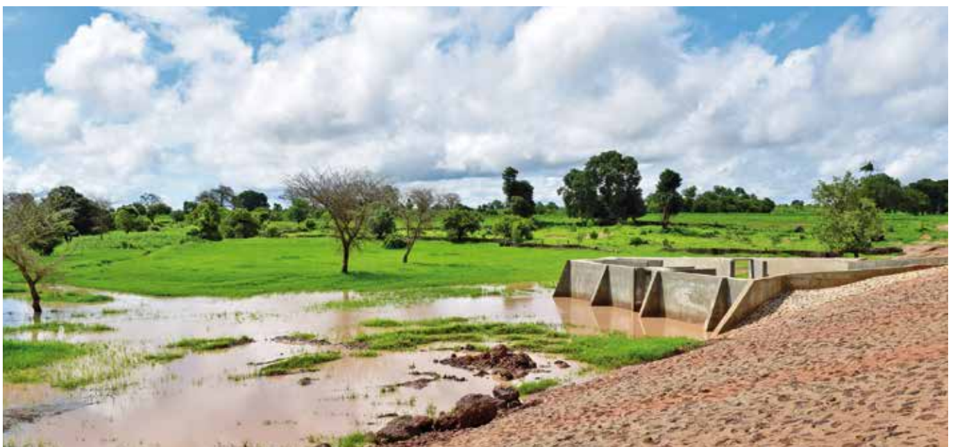
Kayemor (Kaolack), digue de retenue et de franchissement. Photo : © CTB / Marcella Pasotti
