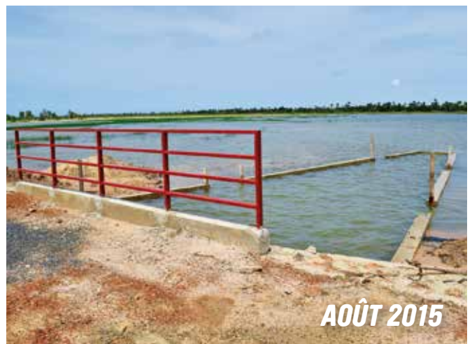
La vallée de Bakhala (Fatick) durant la saison sèche et en saison de pluie. Ci-dessus, une des trois digues anti-sel construites par le BARFAVOR, suite à la requête de la population de Bakhala. Photo : © CTB / Marcella Pasotti
