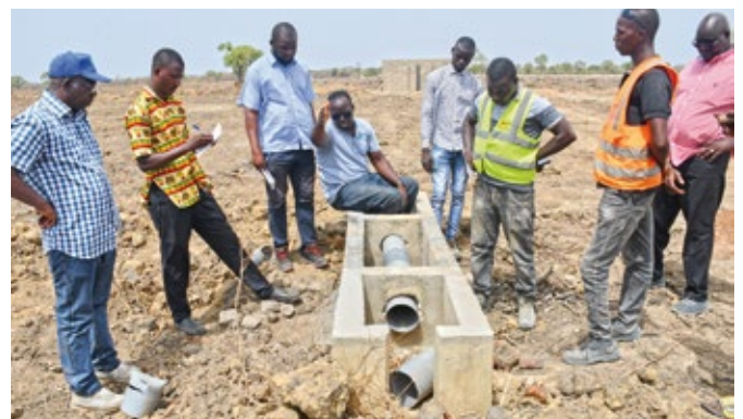
Une prise parcellaire sur le site de Boromissi achevée à 75%
