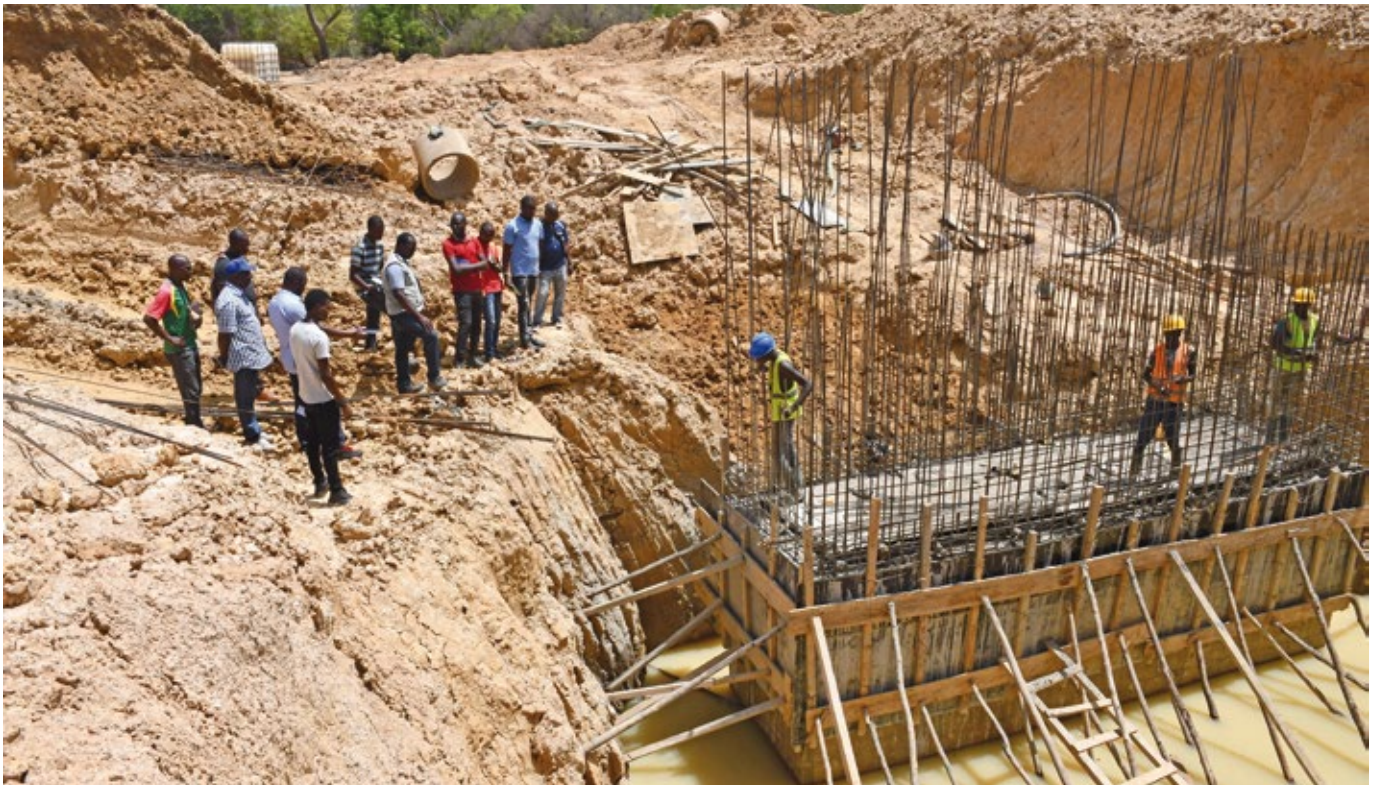
Les travaux du puits de pompage avancent rapidement sur le site de Mouhoun 2
