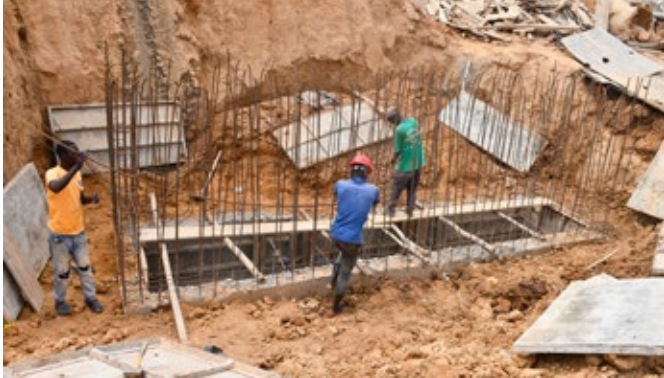
Le puits de pompage en construction sur le site de Mouhoun 3
