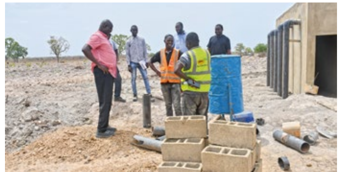
Une mission de PARIIS observe les travaux sur le site de Boromissi (bassin partitaire en finition)
