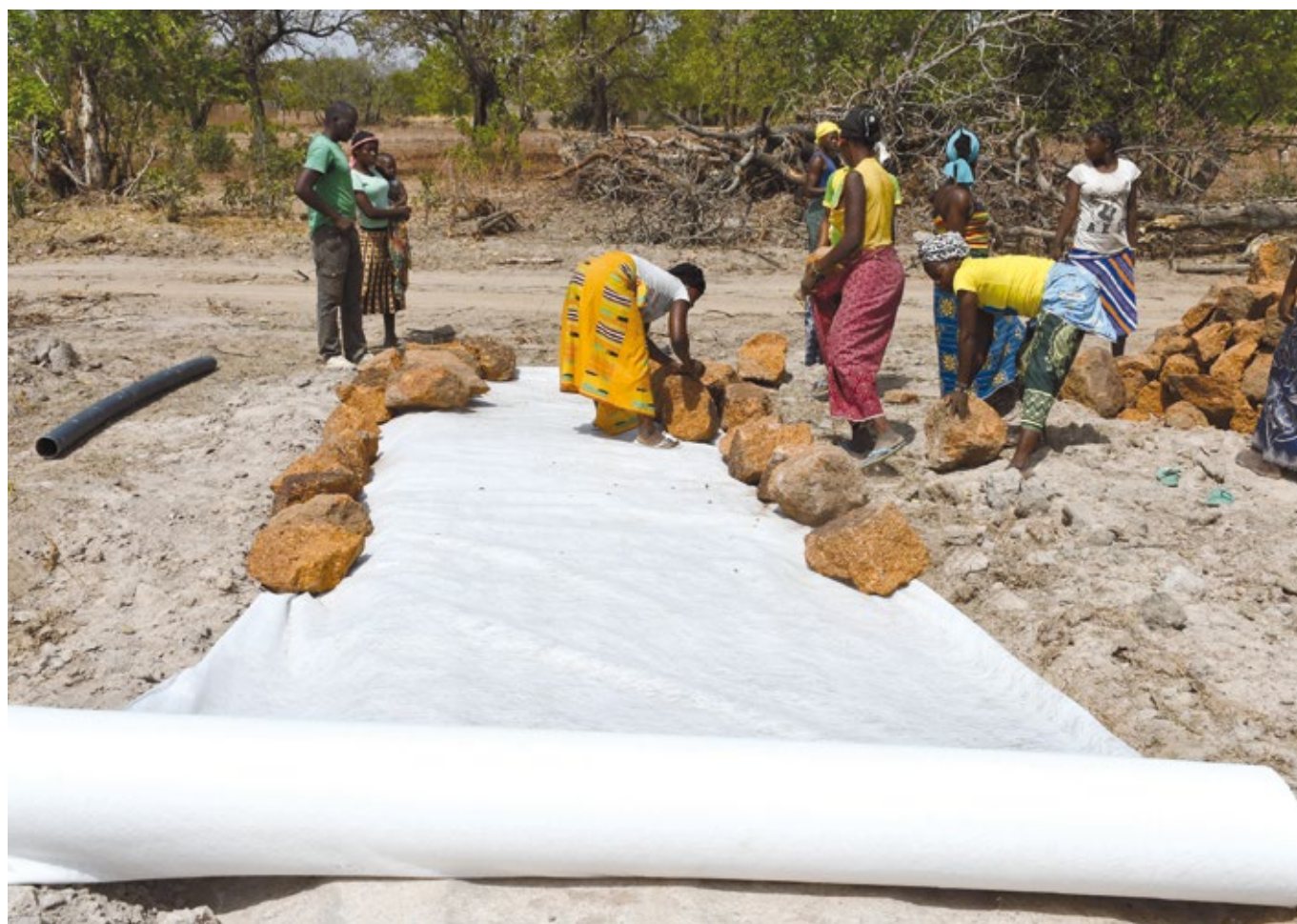
Protection des remblais par du géotextile sur le site de Kéлиндou
