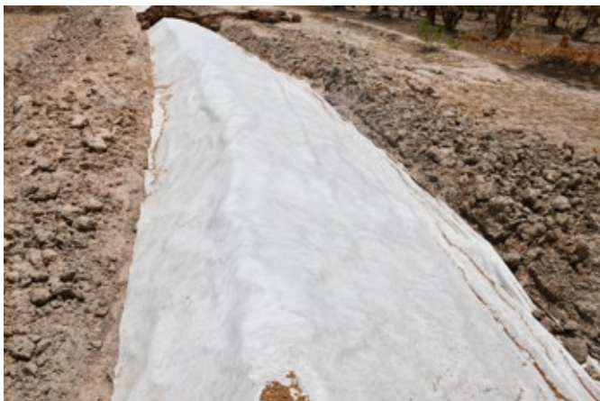
À Sané 2, les dernières DCN en cours d'enrochement
