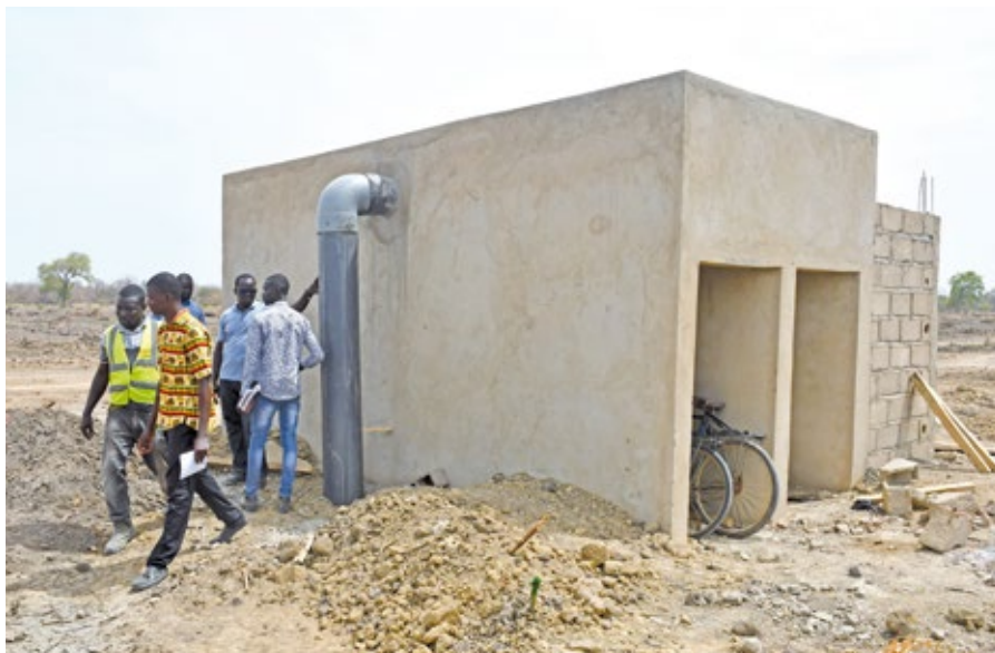
Le bassin partitaire achevé sur le site de Boromissi
