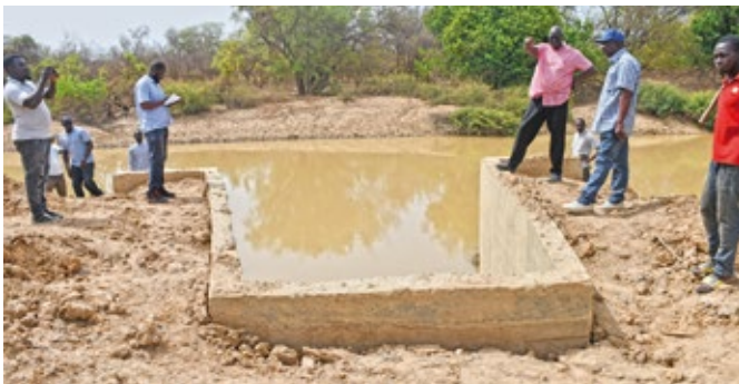
Une mission de contrôle sur le site de Boromissi donne des orientations pour le perfectionnement du bac de captage
