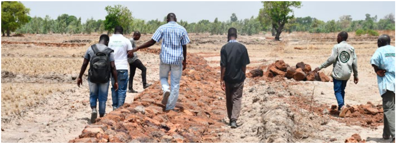
À Gulibilin 3, l'entreprise s'attèle à enrocher les dernières DCN
